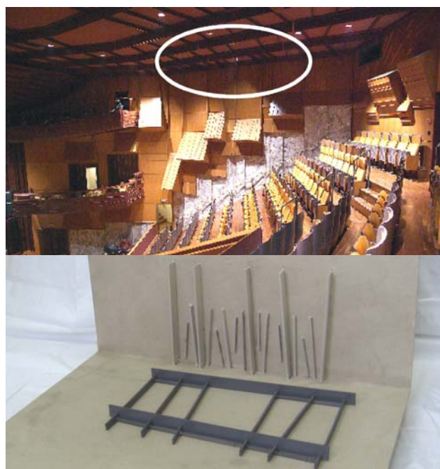
Slika 5 – Izgled jedne projektovane sale (opera u Mariboru) sa označenim reljefnim detaljem iz zone spoja zida i plafona (gore) i parcijalni fizički model istog detalja u razmeri 1:10 (dole).
